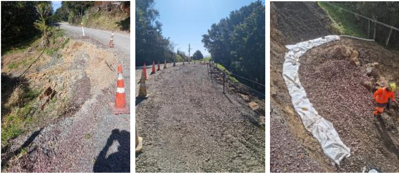
Before/After Te Tio Rd Under slips
